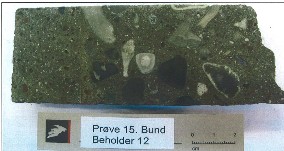
Eksempel på betonsammensætning. Overfladen af betonen er påført et tykt mørtellag.
